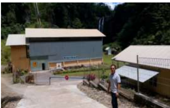
Gambar 1.1: Kondisi objek wisata Air Terjun Bantimurung'Na Gallang yang terhalang oleh bangunan PLTA yang dapat mempengaruhi keindahan dan kenyamanan
