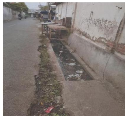
Gambar 3: Kondisi Drainase yang buruk di lingkungan permukiman kumuh (Sumber: Dokumen Tim Survei Balitbang Buleleng, 2021)
