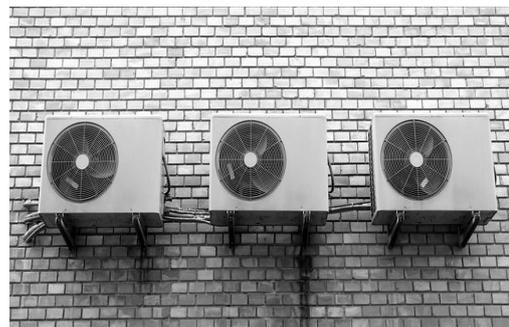
Gambar di atas merupakan bagian outdoor dari rangkaian sistem AC split. Ada beberapa bagian yang harus diketahui dalam sistem ini yaitu kompresor, kondensor, outdoor fan, kapasitor kompresor, pipa kapiler dan overload.
