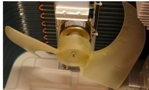
Fan outdoor berbentuk seperti kipas angin baling-baling biasa. Fungsi esensialnya adalah untuk mendinginkan kondensor yang merupakan bagian terpanas didalam sistem AC. Selain itu, juga membantu pembuangan panas ke udara lepas sekaligus membantu mengurangi tekanan refrigeran ketika di treatment di kondensor.
