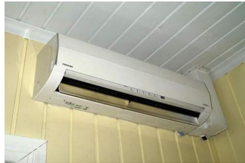
Gambar di atas adalah gambar AC split indoor yang fungsinya dikhususkan didalam ruangan. Ada beberapa komponen penting yang terdapat didalamnya, terdiri dari evaporator, filter udara, blower indoor, motor fan indoor, thermistor, capasitor dan PCB.
