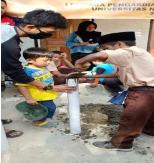
Gambar 4. Proses pembuatan patok beton
