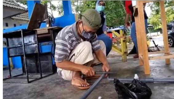
Gambar 3. Proses Pemotongan Pipa
