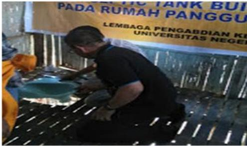
Gambar 9. Proses pemasangan closet viber glass pada lantai kayu rumah panggung
