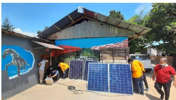
Gambar 4. Simulasi Perakitan Pompa Irigasi berbasis Panel Surya
