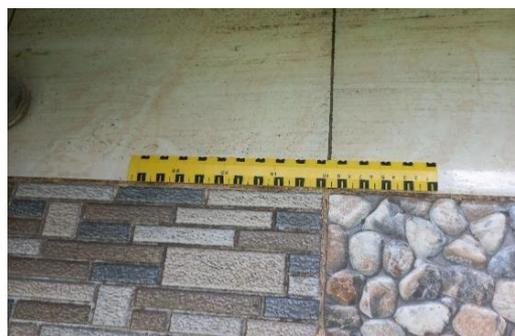
Foto diatas merupakan hasil dokumentasi yang memperlihatkan jalur pemandu yang berada di koridor lantai 2 yang menghubungkan antara ruang kelas dan asrama. Jalur pemandu tersebut menggunakan tegel batu alam yang berdiameter lebih dari 30cm.
