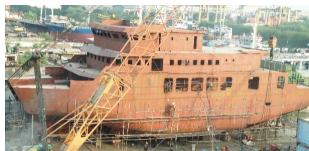
Gambar 1. Kapal Ro-ro saat Proses Pembangunan
