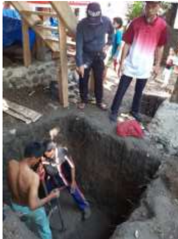
Gambar 2. Proses penggalian tanah lubang septictank
