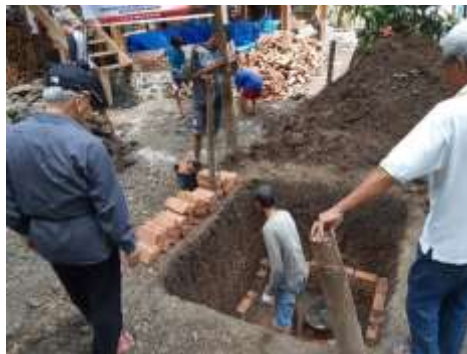
Gambar 3. Proses pemasangan batu merah pada lubang septictank
