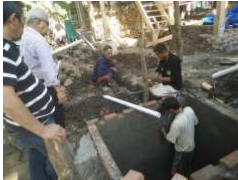
Gambar 4. Dinding septictak yang sudah di plaster
