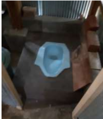
Gambar 11. Pemasangan kloset
