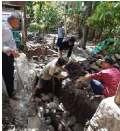
Gambar 9. Material penyusun bagian atas perembesan terdiri dari batu gunung, kerikil, dan pasir.
