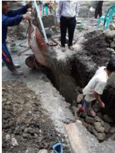
Gambar 6. Masyarakat sasaran sedang menyusun batu kali dan pasir lapisan konstruksi perembesan
