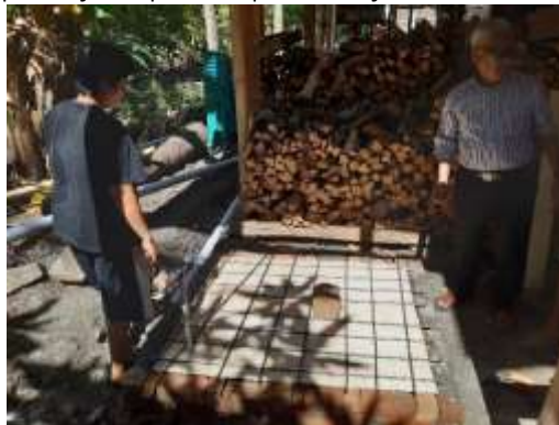
Gambar 10. Memasang besi beton di atas bekesting penutup bak septictank .
