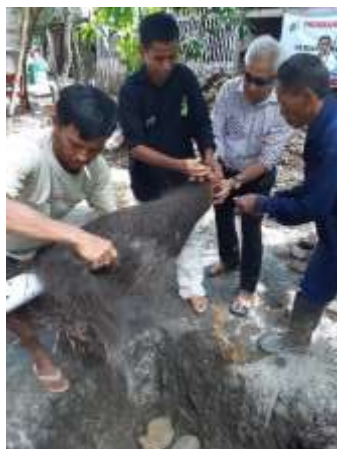
Gambar 8. Pipa rembesan dibalut ijuk setelah diberi lubang keliling permukaan.
