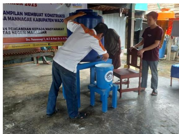
Gambar 6. Meletakkan bak penampungan air di atas konstruksi penyanggah
