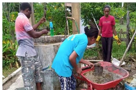
Gambar 2. Pencampuran substrat kotoran sapi dan air (1 : 1)
