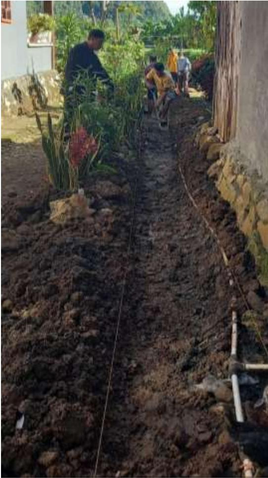
4. Melakukan pekerjaan pemasangan batu konstruksi drainase pembuangan air kotor. Pada kegiatan ini mitra didampingi oleh tim pelaksana melakukan pekerjaan konstruksi drainase pembuangan air kotor.
