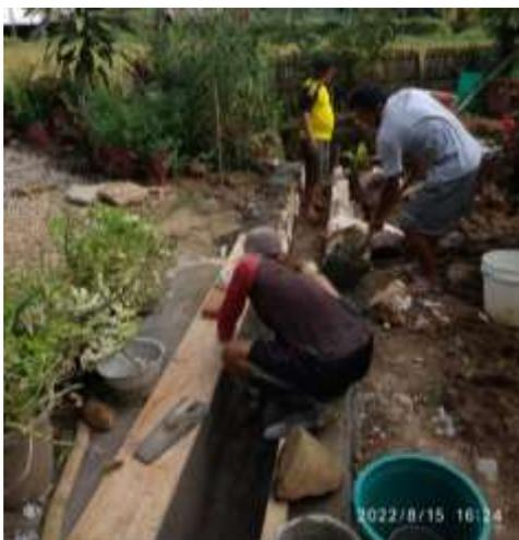
5. Melakukan pekerjaan pemasangan batu merah untuk konstruksi bak penampungan air kotor. Pada kegiatan ini mitra didampingi oleh tim pelaksana melakukan pekerjaan konstruksi bak penampungan air kotor.
