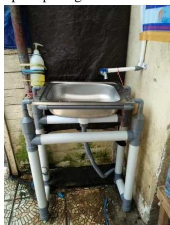
Gambar 8 Pemasangan Bak Cuci Tangan di pasar Tradisional
