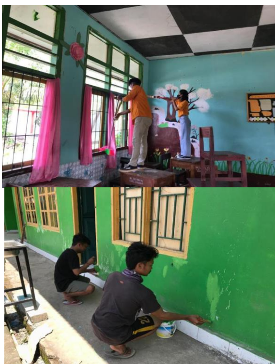
Gambar 4. Proses pembersihan ruangan dan pengecatan ulang tembok ruangan
