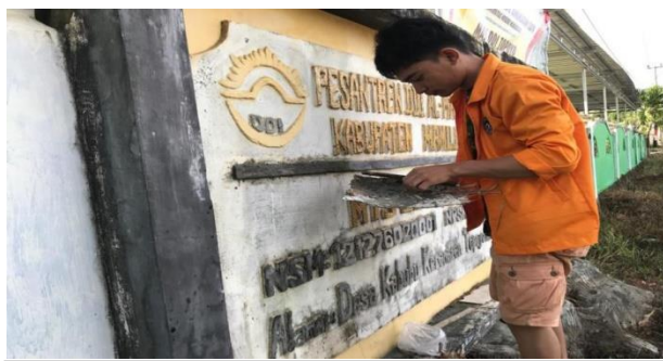
Gambar 5. Perataan halaman dan perbaikan tembok papan nama sekolah
