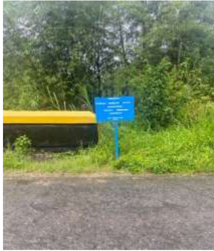
Gambar 7. Foto pemasangan papan himbauan di jembatan lingkungan Tabone.
