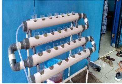
Gambar 8. Meletakkan gelas plastik pada lubang pipa.
