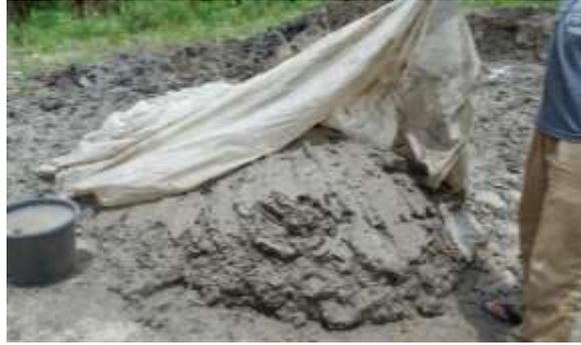
Gambar 3. Adonan tanah yang telah diaduk dengan traktor tangan
