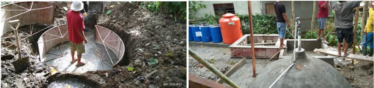
Gambar 3. Pembangunan instalasi Biogas
