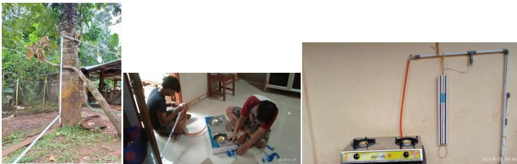
Gambar 4. Penyambungan saluran Biogas dari instalasi Biogas sampai ke kompor Biogas
