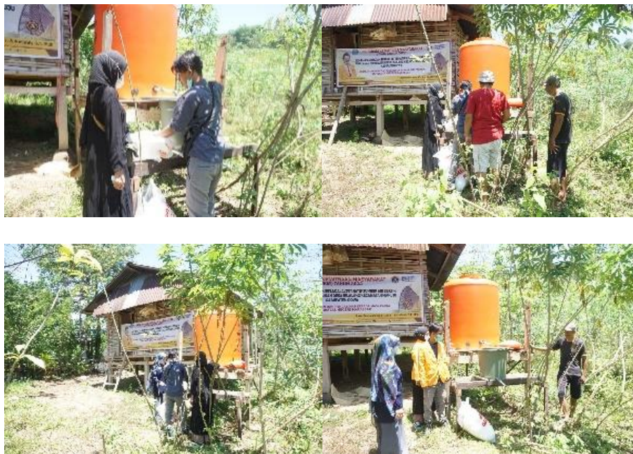
Gambar 3. Pendampingan pembuatan dan instalasi bak penjernihan air hujan
