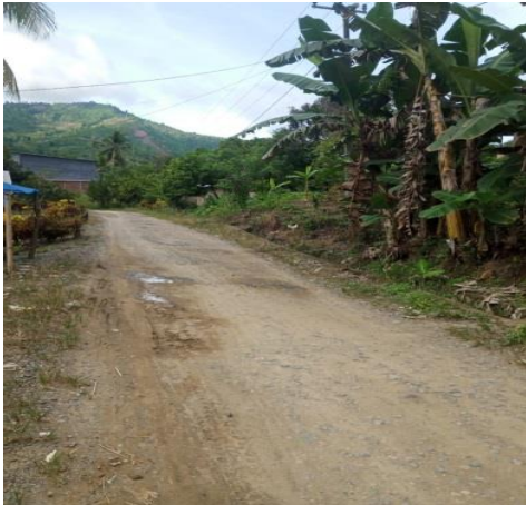
Lokasi 1. Komunitas Tandara
